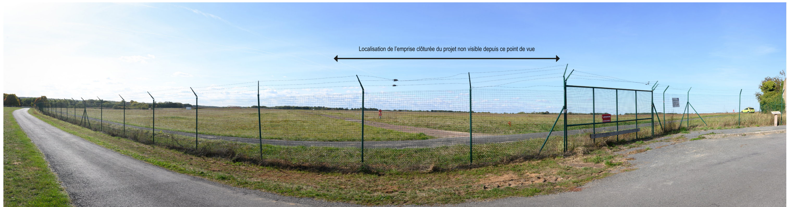
Point de vue n°6 - Vue depuis l'est du projet en limite de l'aérodrome
