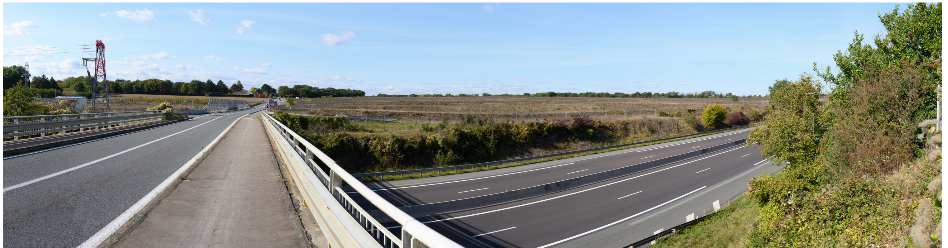
Point de vue n°1 - Vue depuis le pont traversant l'autoroute A10 au sud-est du projet
